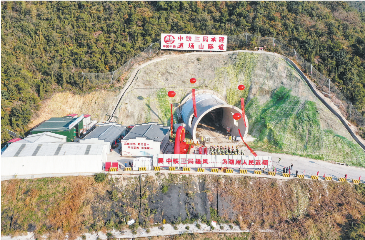
图为沪苏湖铁路道场山隧道施工现场，它的贯通标志着该铁路全线架梁主通道打通。
