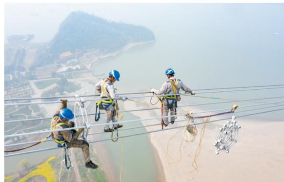
3月14日,在安徽芜湖的长江边,安徽送变电工程有限公司施工人员在高空进行特高压输电线路跨江作业(无人机照片)。3月14日,白鹤滩—江苏±800千伏特高压直流输电工程安徽段跨越长江放线工程完成最后6根导线的展放,标志着特高压“白江线”安徽段长江大跨越线路贯通。
