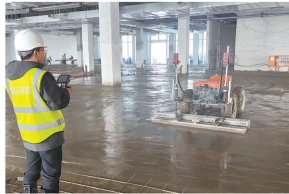
记者日前走进位于德清县的2022年杭州亚运会三人制篮球场项目施工现场,只见一台四轮的智能设备正在有条不紊地完成混凝土的平整工作。这台智能设备名叫激光地面平整机,是由我市筑石科技(湖州)有限公司自主研发的,可有效解决地面平整度和水平度误差偏大的问题,相比人工操作,可提升一倍的工作效率。 记者 邵鼎 摄
