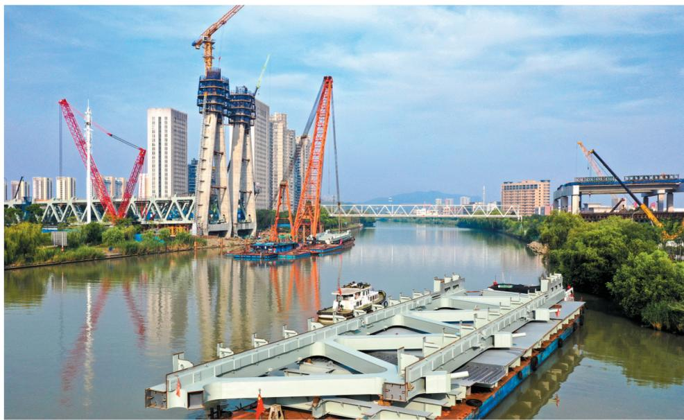
昨天上午,湖州市内环(北线)快速路风荷大桥,浮吊船正在长湖申航道起吊跨河桁架。风荷大桥采用双层通道设计,是快速路连接二环西路的重要交通枢纽。当天早上6时起,市交通部门对该河段实施间歇性封航,直到9月25日桥面吊装施工完成。
