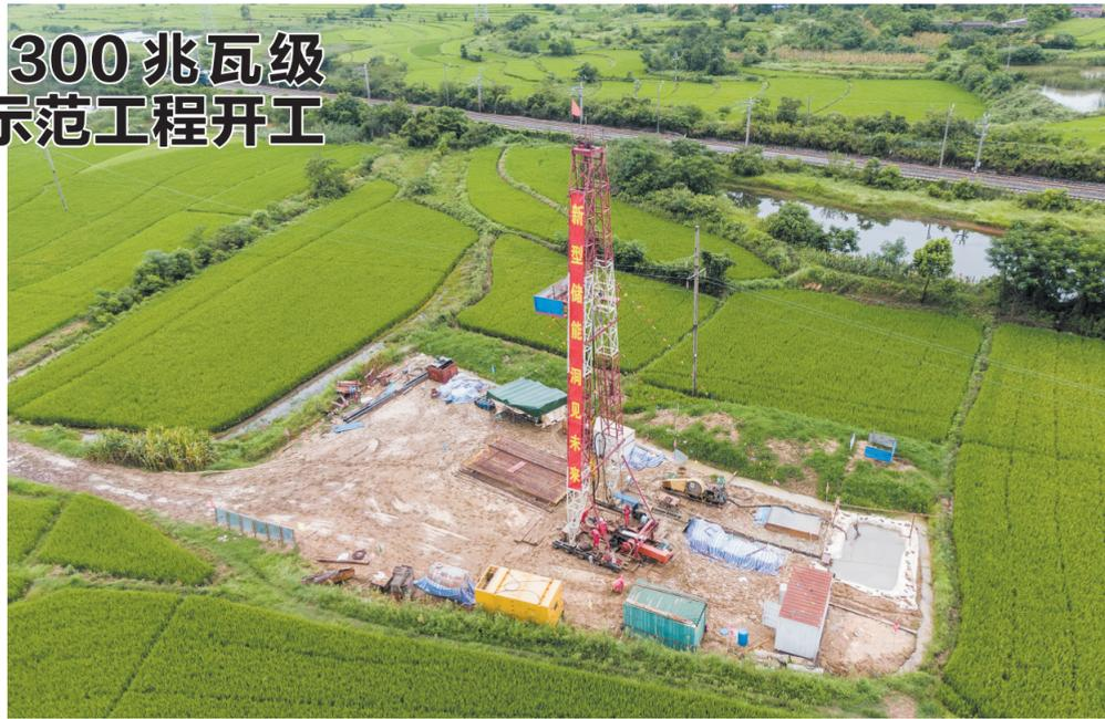
7月26日，工人在施工工地深层取芯，勘探地地质条件(无人机照片)。
