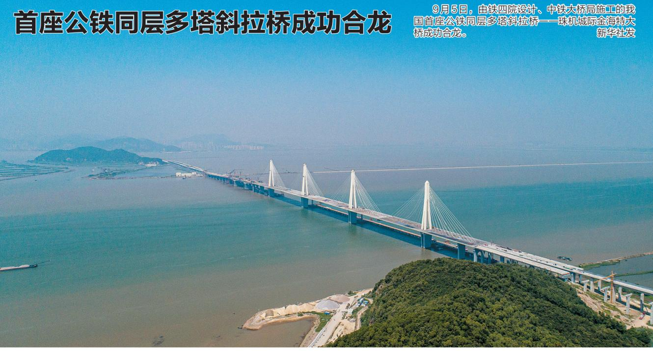
9月5日,由铁四院设计、中铁大桥局施工的我国首座公铁同层多塔斜拉桥——珠机械际金海特大桥成功合龙。 新华社发
