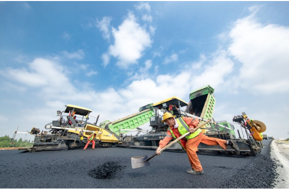
104国道施工现场。张锦国 摄
