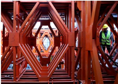
液压设备支撑的贝雷架,是造楼机的主平台。
