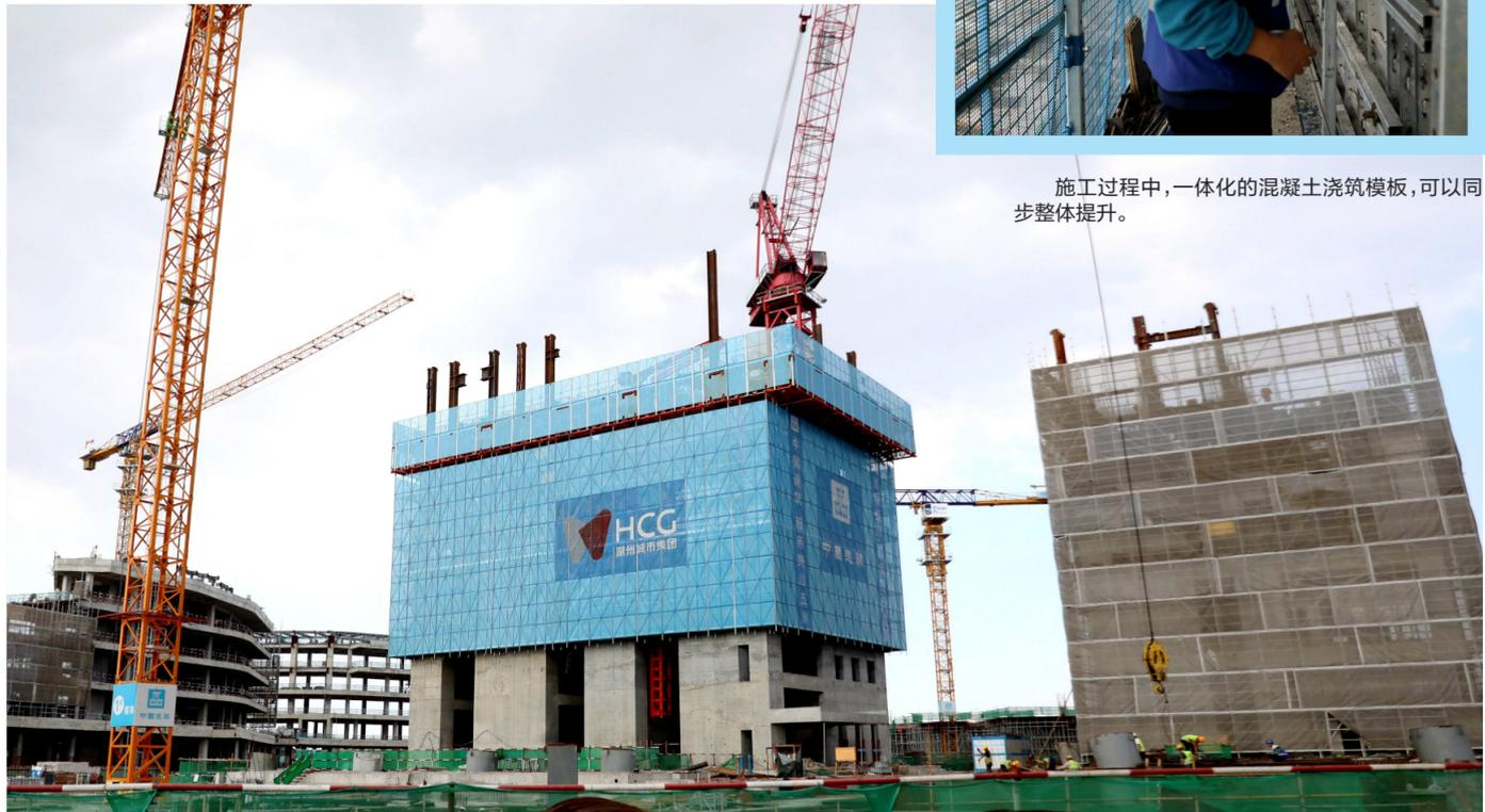
南太湖CBD主地标塔楼,造楼机投入使用后,可以实现四五天一层楼的建设进度。
