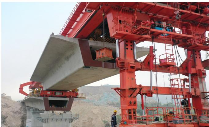
架梁机将箱梁吊运至桥墩安装。
