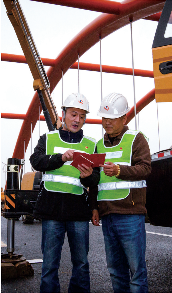
市公路与运输管理中心组织党员干部前往G104京岚线九九桥维修加固工程施工现场,向在岗党员发放《中国共产党章程》。 吴洁 摄
