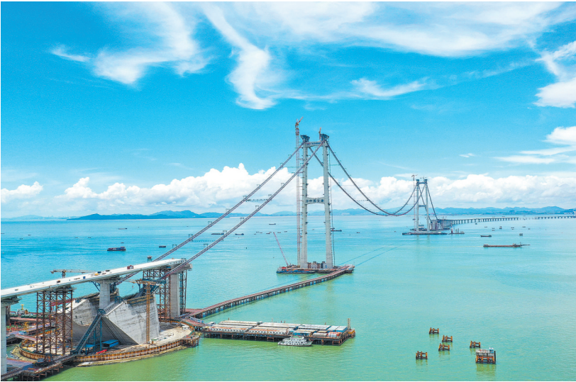
这是深中通道关键控制性工程伶仃洋大桥的建设现场（2022年10月16日摄，无人机照片）。新华社发（张政 摄）
