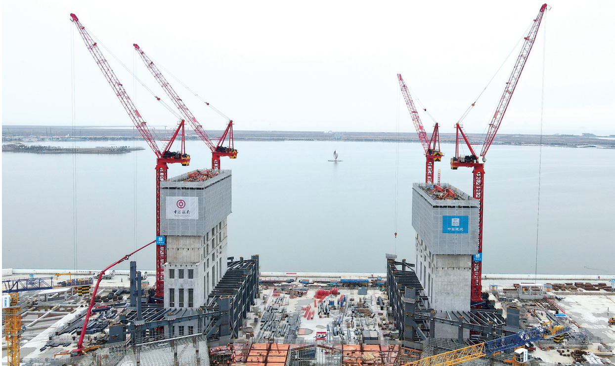
2月17日拍摄的建设中的中建二局临港西岛中银金融中心项目南北塔楼核心筒。
