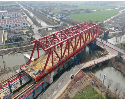
2月19日拍摄的常泰长江大桥南北公路接线工程跨G345特大桥钢桁梁顶推作业现场。(季春鹏 摄 新华社发)
