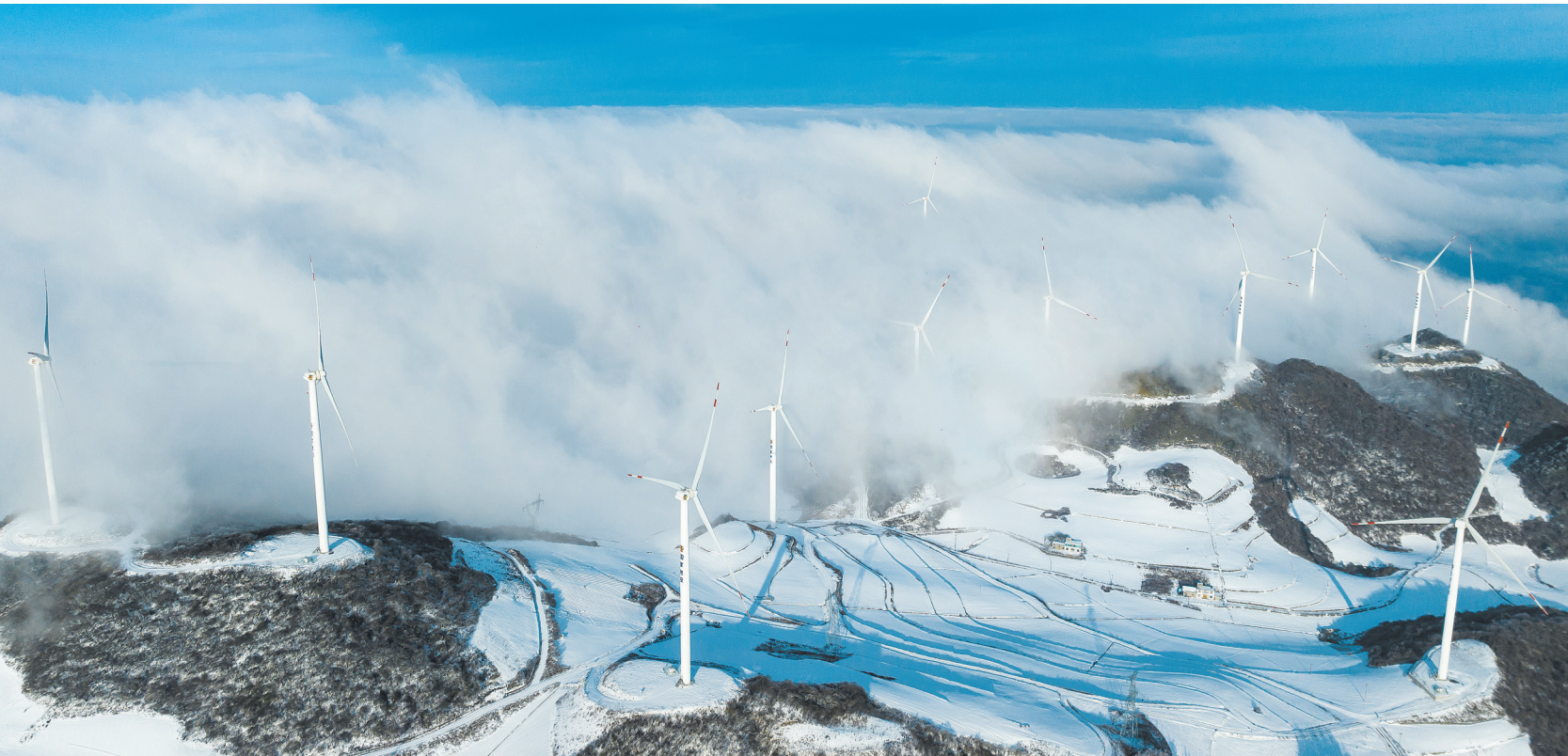
2月24日在湖北省宜昌市秭归县两河口镇云台荒村拍摄的风力发电机组。一场春雪过后，湖北省宜昌市秭归县云台荒风力发电场银装素裹，风电机组在云海旋转，美景如画。新华社发（郑家裕 摄）
