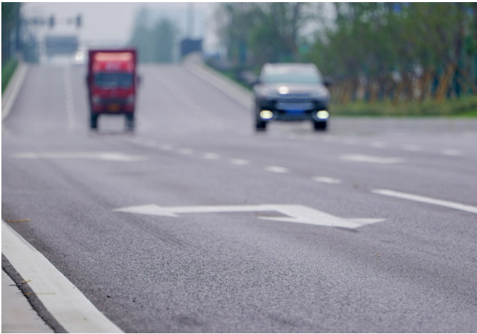
改造提升后的湖织大道路面更加平整。
