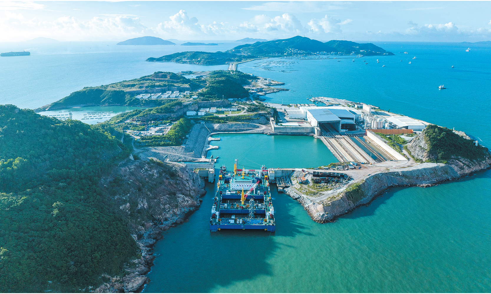
“一航津安1”号沉管运输安装一体船拖带E23管节和最终接头从珠海桂山岛启航，前往沉放水域（6月8日摄，无人机照片）。
