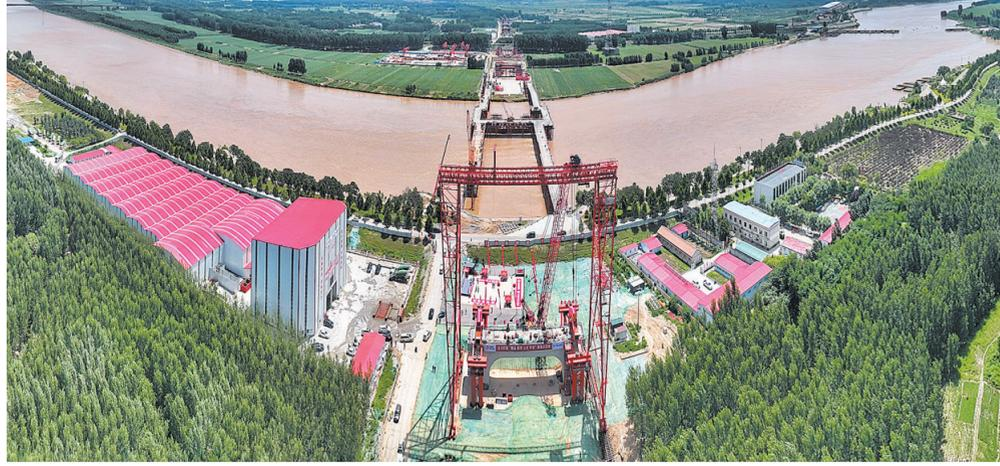
7月7日,在位于山东省济南市的济滨高铁济阳黄河公铁两用特大桥建设现场,中铁大桥局的施工人员成功架设大桥首节钢桁梁,标志着该大桥建设迈入钢桁梁架设阶段。
