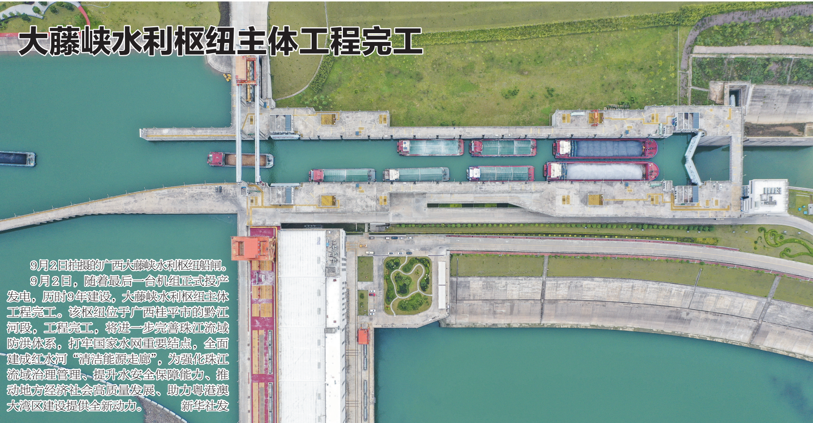
9月2日拍摄的广西大藤峡水利枢纽船闸。
