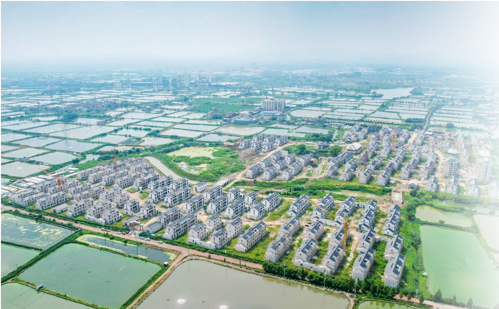
航拍新荻村正在建设的新农村。
