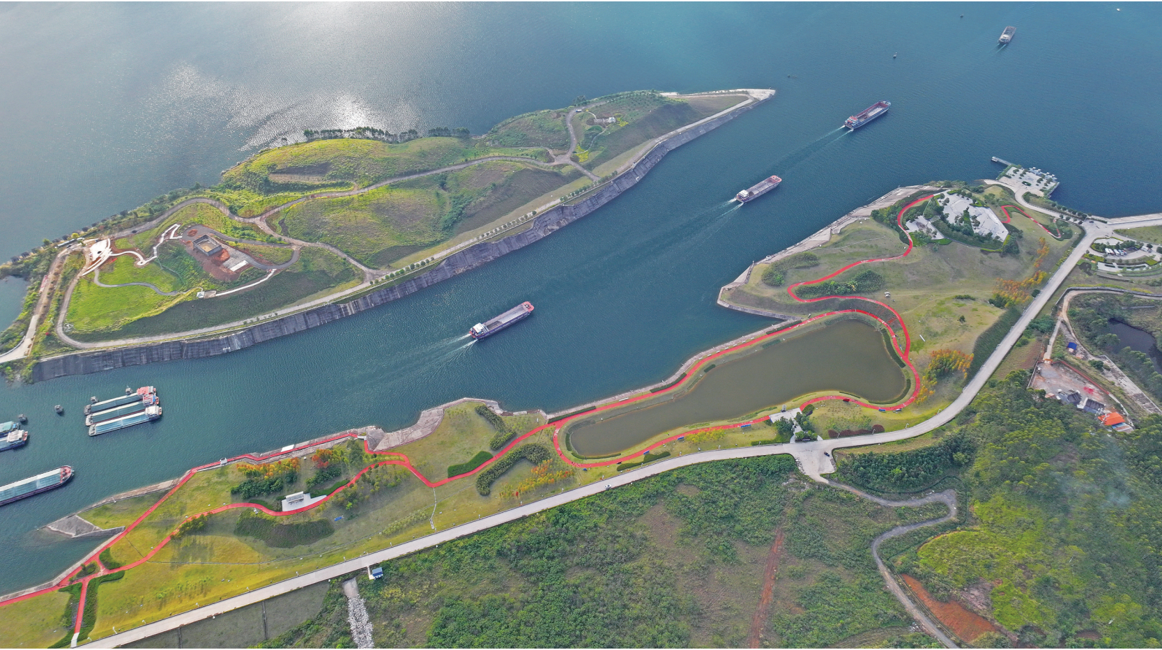
船只从大藤峡水利枢纽船闸通过(12月4日摄,无人机照片)。位于广西桂平市的大藤峡水利枢纽是国家节水供水重大水利工程、国家水网骨干工程,历时9年艰苦建设,枢纽主体工程于今年9月正式完工,奔流的西江上多了一道壮丽风景线。
