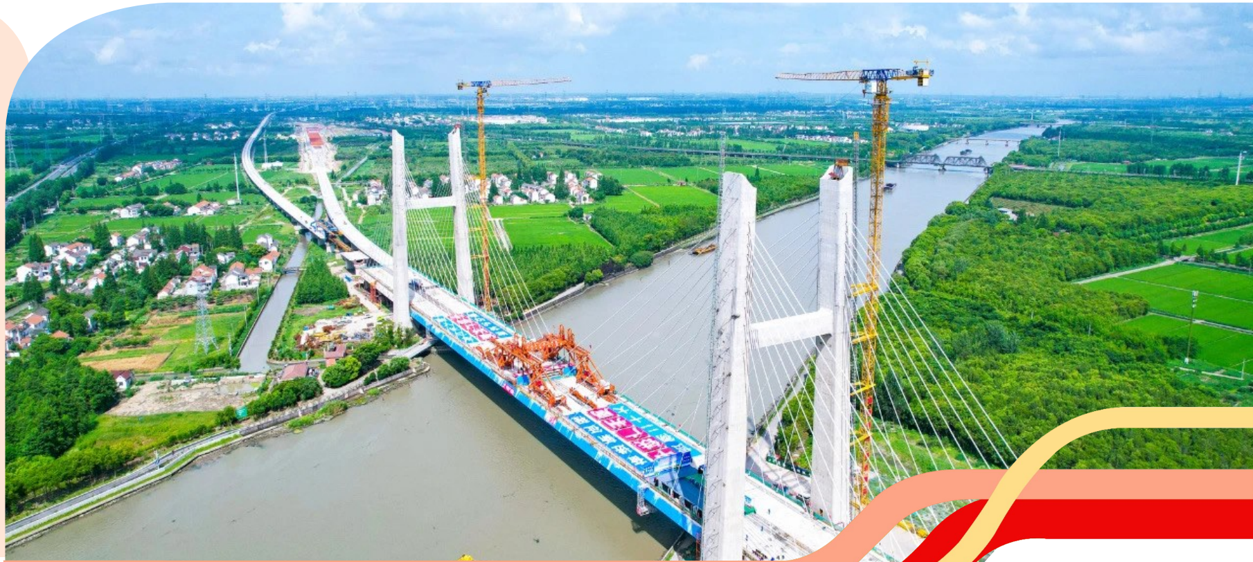
沪苏湖铁路跨塘斜拉桥合龙
