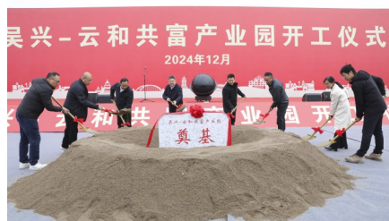
吴兴—云和共富产业园开工
