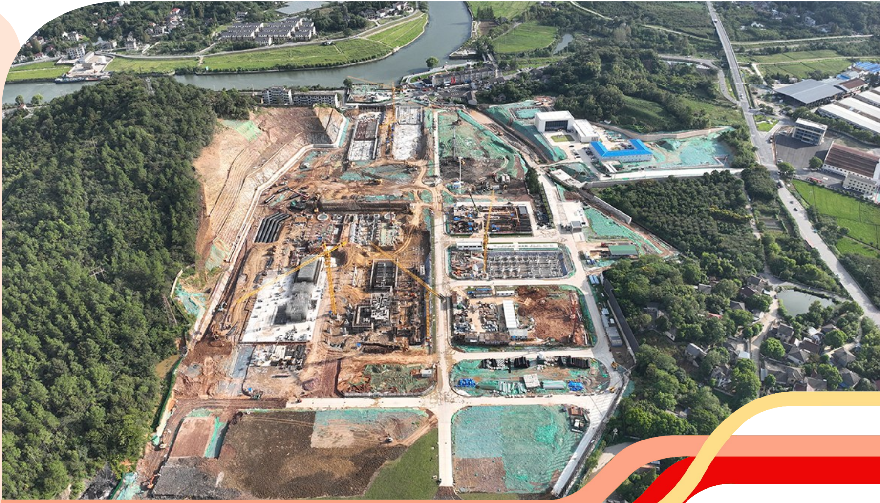
安吉天燃气项目建设现场
