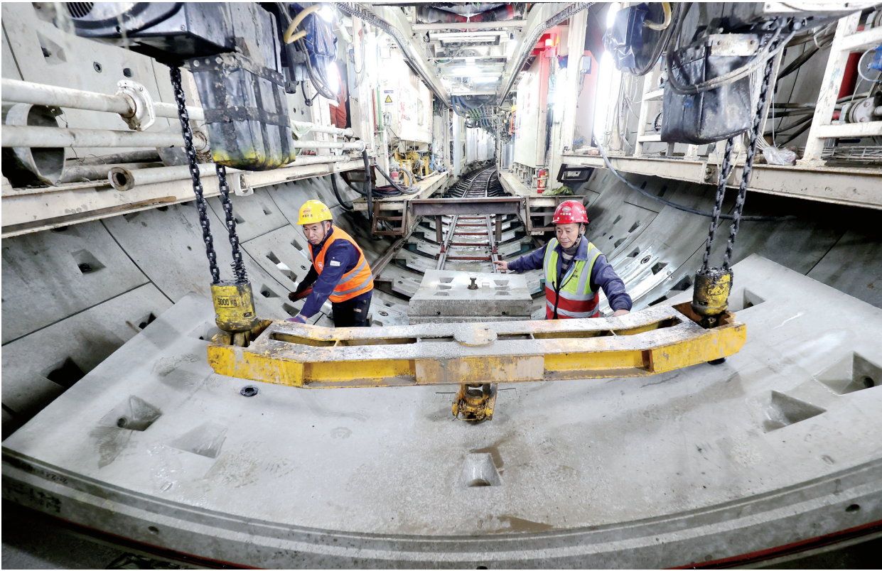
2月1日，德清县杭德市域铁路车辆基地建设现场，中铁十六局工人坚守一线赶工期。
