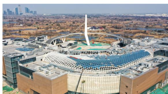
连日来，南太湖新区东草田漾文化步行街，装修工人在全长356米的人行景观天桥施工。该项目外立面施工已基本完成，处于市政、装饰施工阶段，计划今年9月完工。
