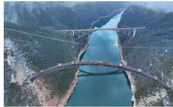
合龙后的乌江特大桥。3月5日,贵州瓮马铁路南北延伸线项目控制性工程乌江特大桥顺利合龙。乌江特大桥全长约520米,主跨337米,桥面至江面高度约200米。瓮马铁路南北延伸线北起瓮安延伸至遵义,南起马场坪延伸至都匀,全长148公里。 新华社发
