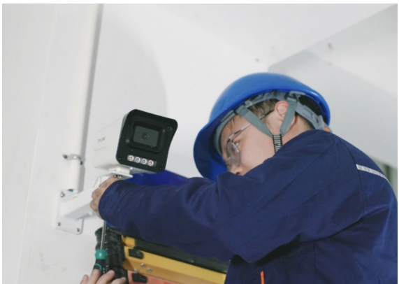
正在安装搭载天翼视联AI能力的摄像头
