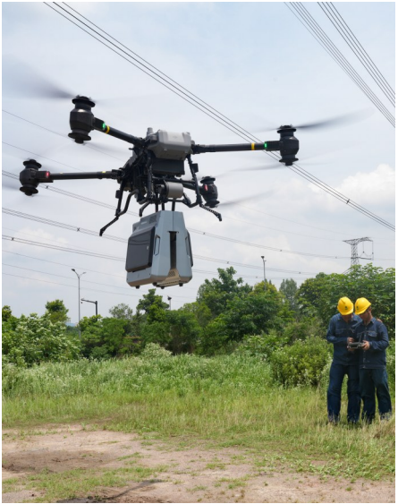
在位于绍兴诸暨市的500千伏线路现场，工作人员操作搭载了地线断股带电修补机器人的大疆无人机起飞，对线路进行修复。 (翁忻旸 摄 新华社发)
