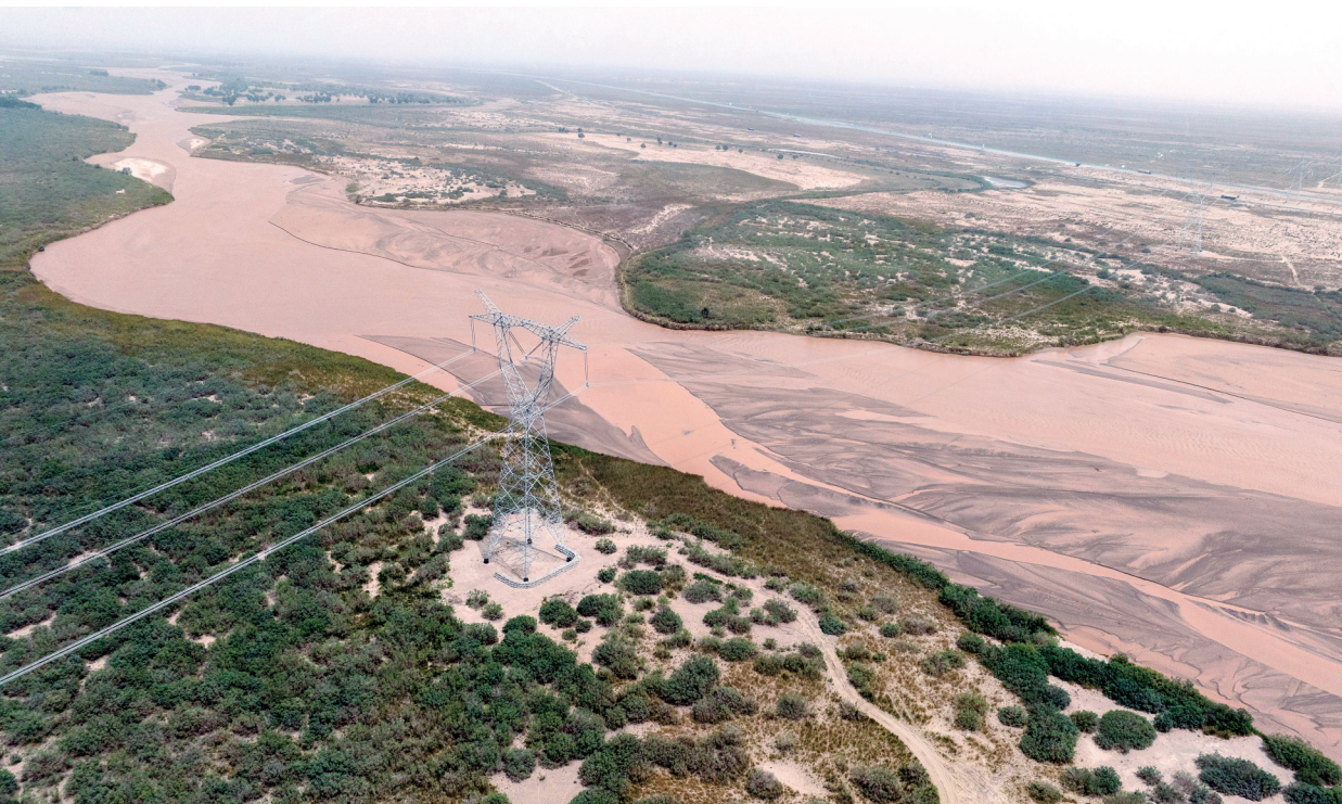
新疆环塔里木盆地750千伏输电线路跨越车尔臣河（6月14日摄）。 新华社发（马元 摄）
