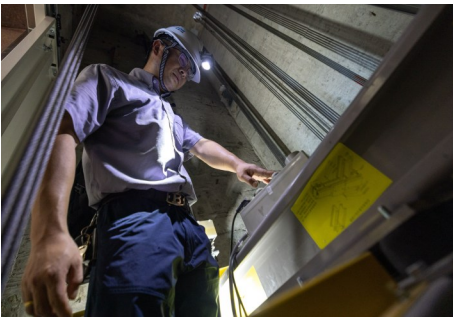
飞英街道河畔居一期电梯更新改造项目完成验收。
