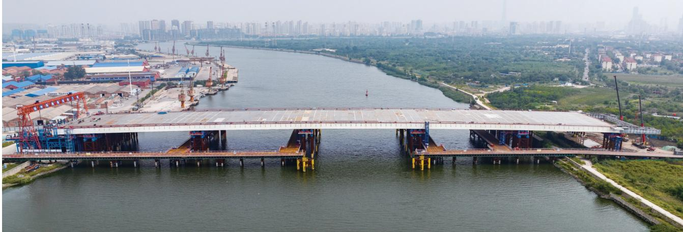
这是9月16日拍摄的天津市滨海新区西中环快速路跨海河桥工程建设现场(无人机照片)。当日,由中铁十八局承建的天津市滨海新区西中环快速路跨海河桥最后一节钢箱梁稳稳落到设计位置,标志着重达12500吨的主桥钢箱梁精准就位,工程建设取得重要突破。
