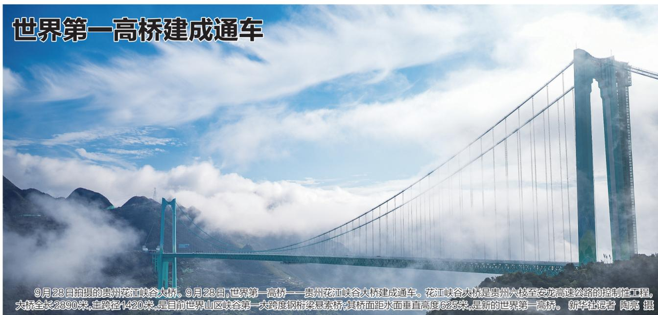
9月28日拍摄的贵州花江峡谷大桥。9月28日,世界第一高桥——贵州花江峡谷大桥建成通车。花江峡谷大桥是贵州六枝至安龙高速公路的控制性工程,大桥全长2890米,主跨径1420米,是目前世界山区峡谷第一大跨度钢桁梁悬索桥;其桥面距水面垂直高度625米,是世界第一高桥。新华社记者 陶亮 摄
