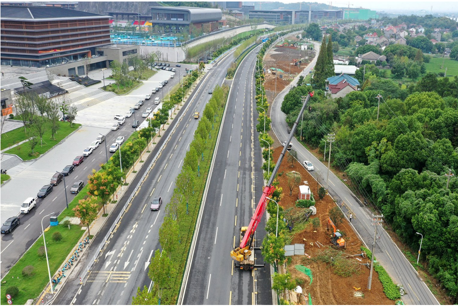
工人在道路两旁的绿化带施工，不断提升乡村景观和人居环境。
