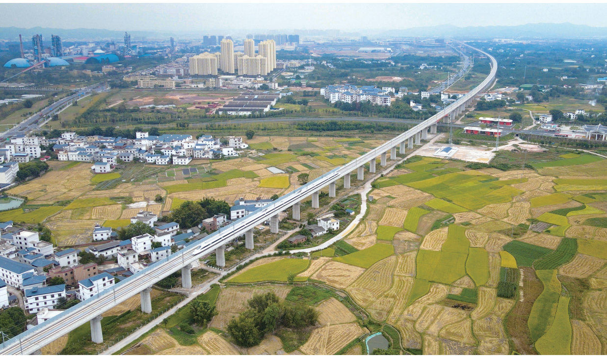
联调联试列车经过赣深高铁信丰特大桥（2021年10月14日摄，无人机照片）。
